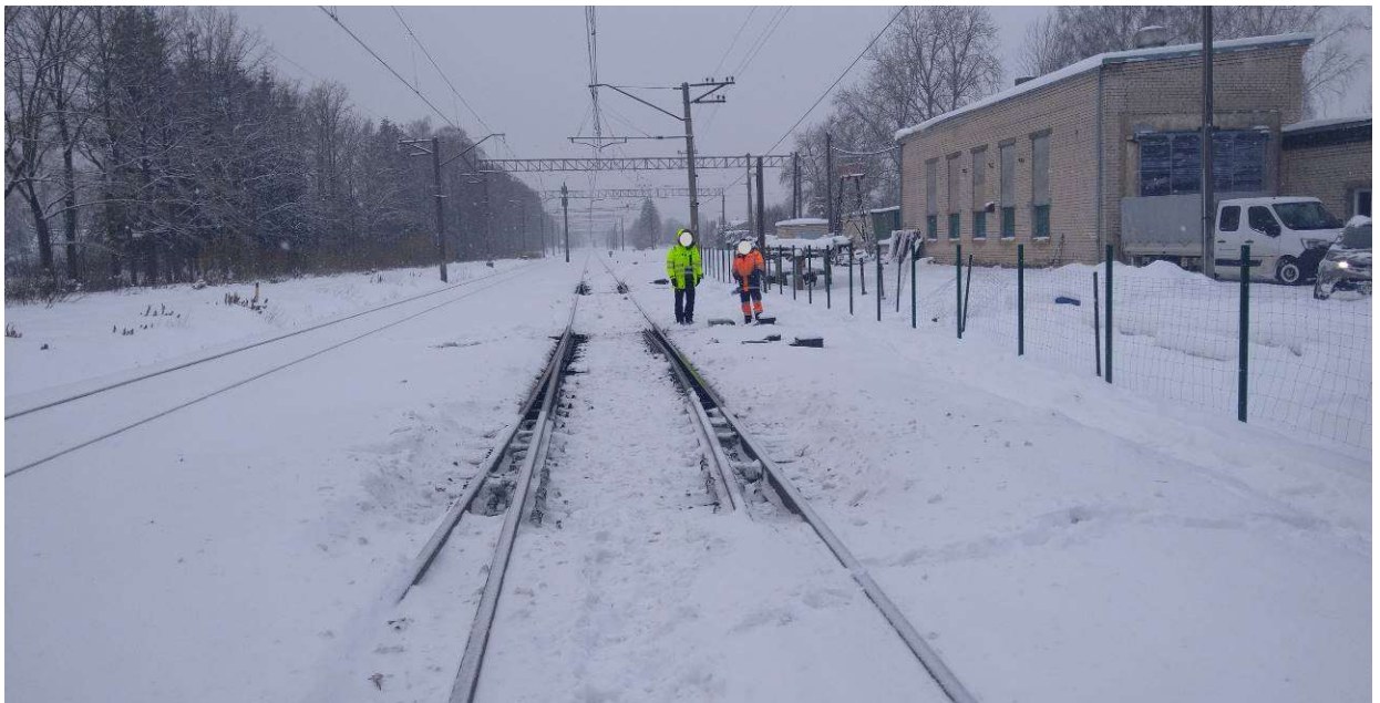
4.att. Laikapstākļi negadījuma vietas apskates laikā (foto uzņemts negadījuma dienā ap plkst. 14.00)
