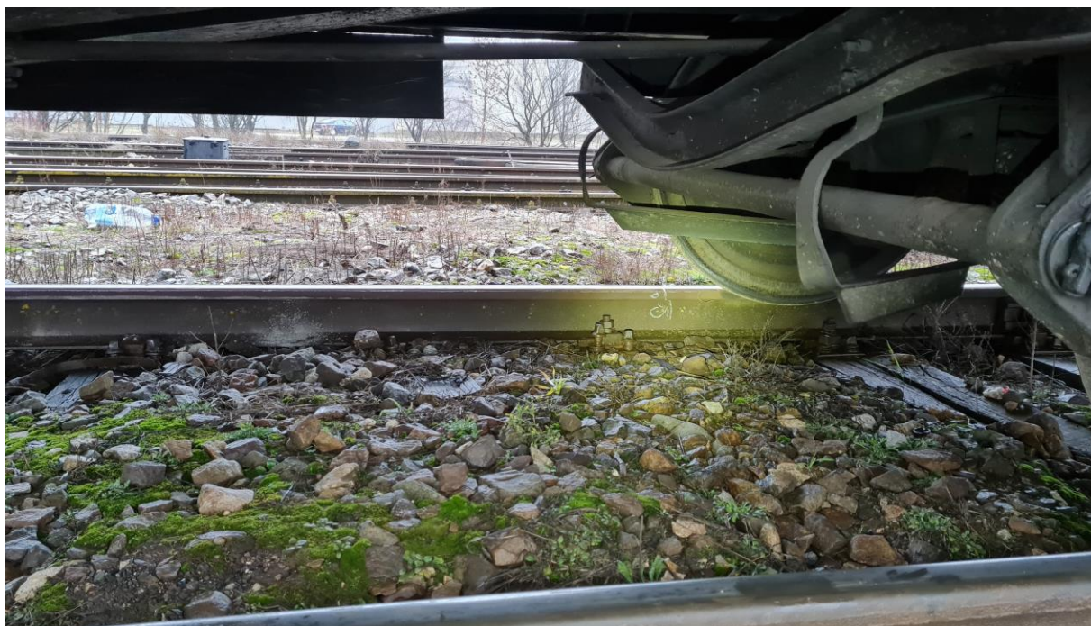
Imaginea nr.13 - traversele acoperite de piatră spartă și noroi în zona punctului „0”
