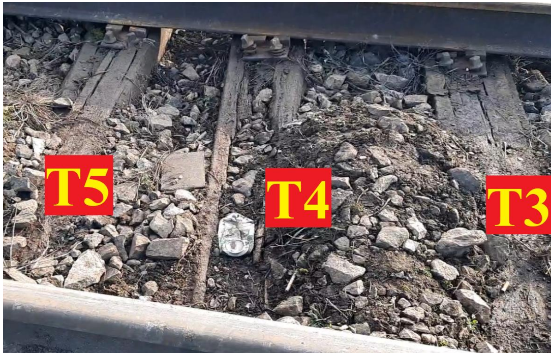
Imaginea nr.21 - traversele T3, T4 și T5, interiorul căii
