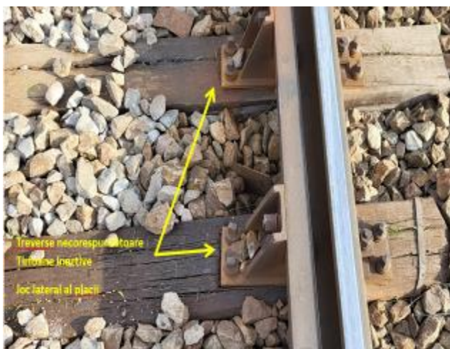
Foto.nr.12 – Traversele T-38, T-39
