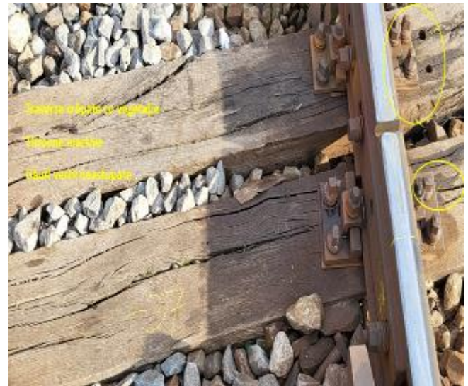
Foto.nr.15 – Traversesele T-36, T-37
