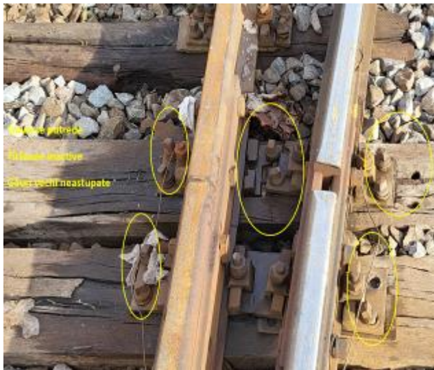
Foto.nr.14 – Traversesele T-36, T-37
