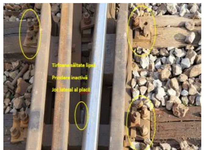
Foto.nr.13 – Traversele T-38, T-39
