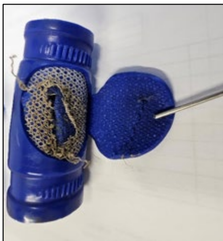
Foto 2. Defekt kølevandsslange. Kilde: GoCollective
