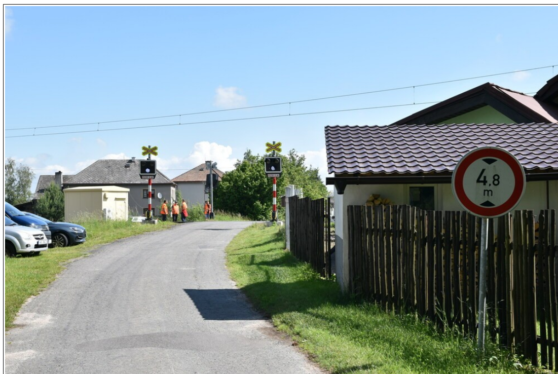
Obr. č. 7: Výhled na výstražné kříže a výstražníky ŽP P4874 z pozemní komunikace ze směru jízdy OA na vzdálenost 40 m Zdroj: DI
