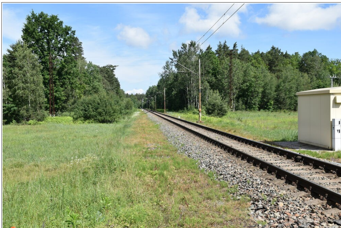
Obr. č. 9: Rozhledové poměry řidiče na trať z pozemní komunikace před vjezdem na ŽP P4874 ze směru jízdy OA vlevo (tj. k místu, odkud k ŽP přijížděl vlak Sp 1895)
