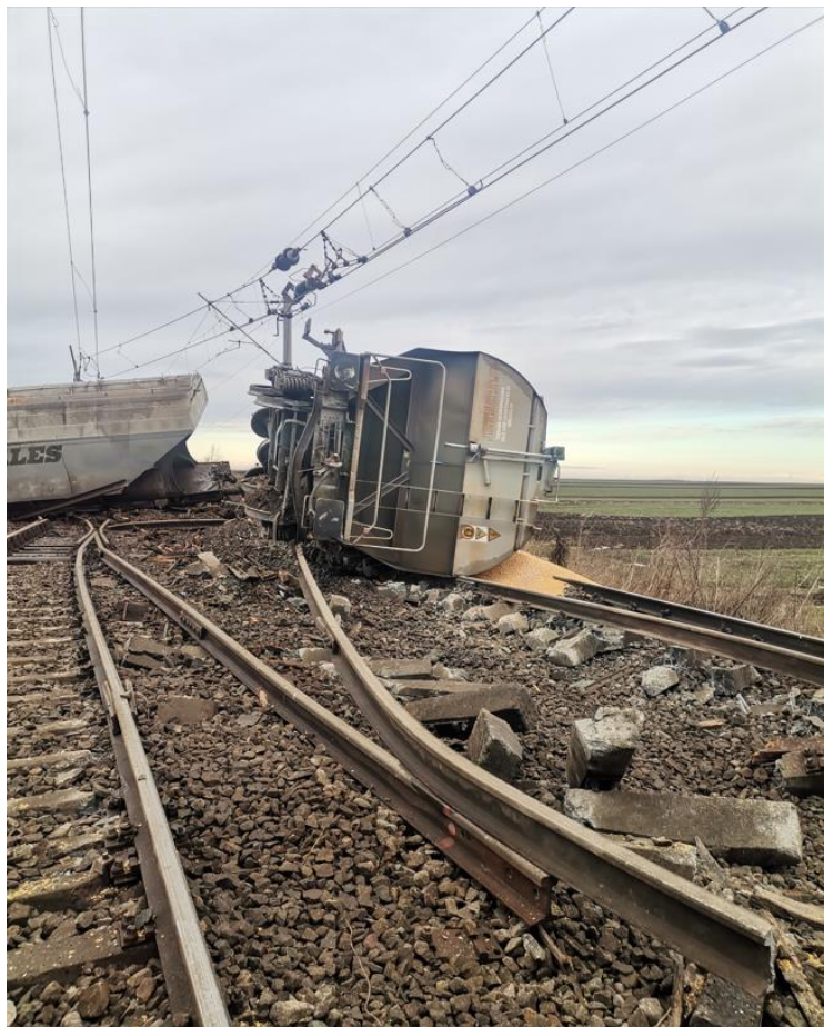
Foto nr.9. Diagonala 2/4 afectată de deraiere
