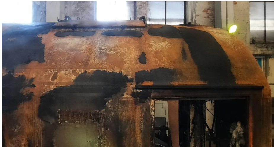
Imaginea nr.7 - acoperișul cutiei vagonului în zona compartimentului tabloului electric
