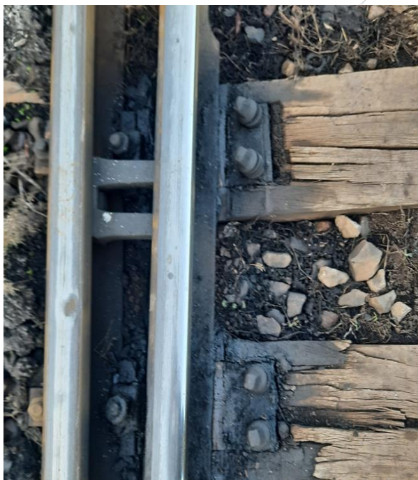
Imaginea nr.9 – partea stângă a traverselor, în sensul de mers, care susțin acul curb
