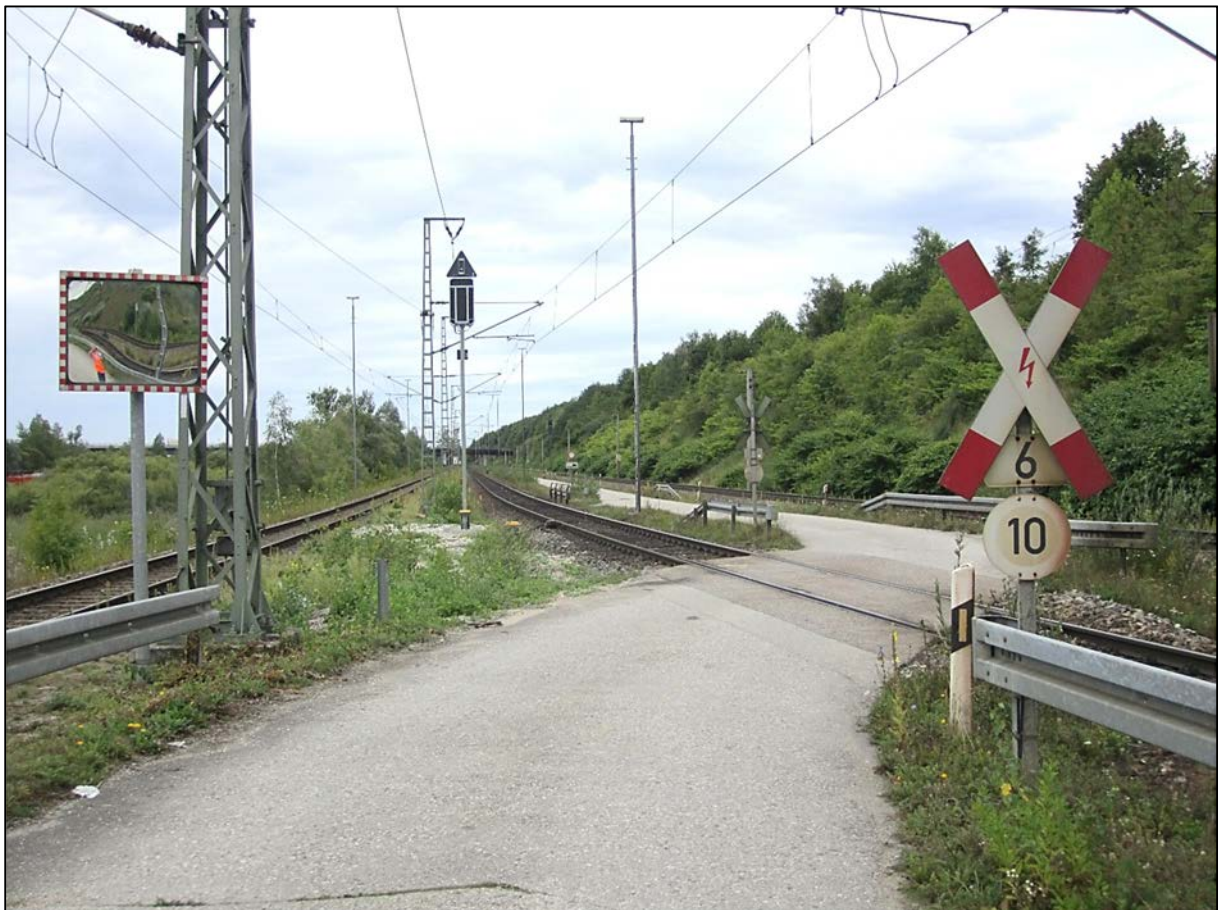
Abbildung 7: Ansicht GÜ 6 mit Beschilderung und Verkehrsspiegel
