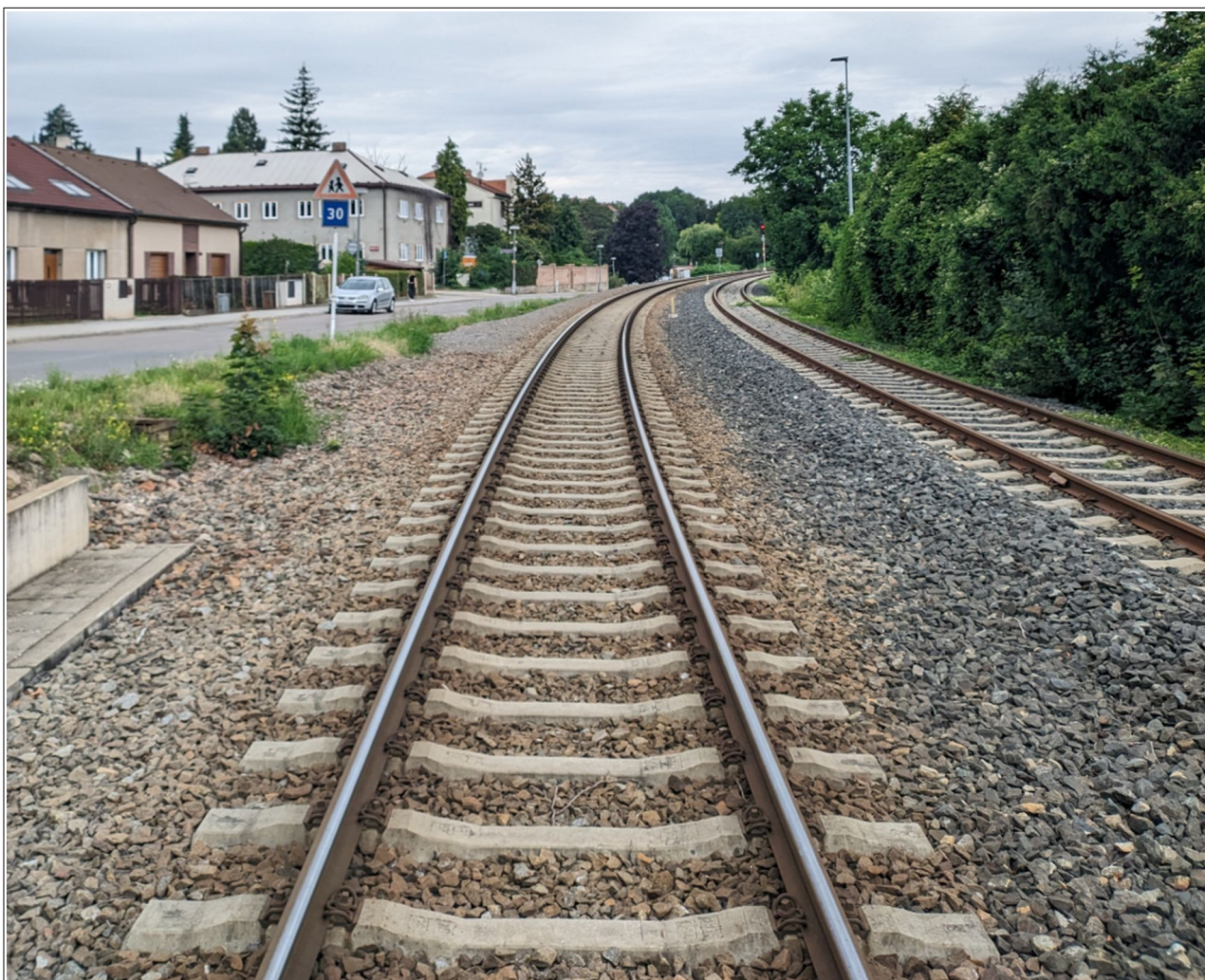
Obr. č. 8: Viditelnost návěští odjezdového návěstidla L1a žst. Chrudim ze SK č. 1a, ze vzdálenosti 146,6 m, a pohled na stromoví (stromy, keře) rostoucí podél SK č. 2b (na obrázku vpravo).
