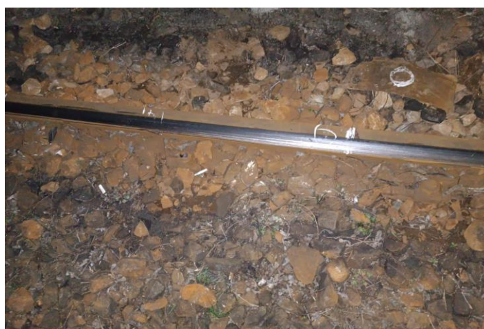
Imaginea nr.10 – prisma de piatră între șine și la capetele traverselor
