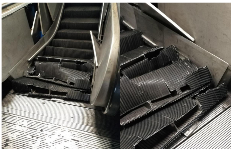
Vista dei gradini della scala mobile a seguito dell'evento (Fonte relazione DiGiFeMa)
