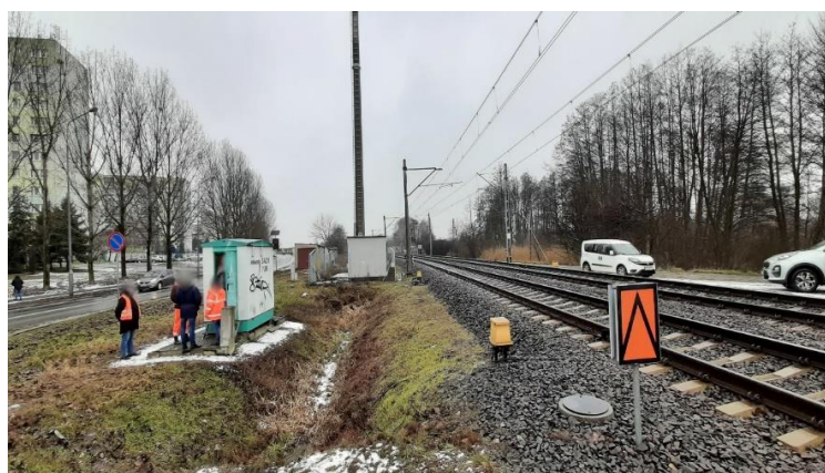
Zdjęcie 5 - Widok na tor nr 2 z drogi z odległości 5 metrów od skrajnej szyny (materiał własny PKBWK)
