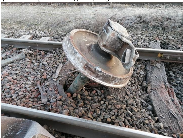
Zdjęcie 14 - Skutki zdarzenia (źródło: materiały przekazane przez komisję kolejową)
