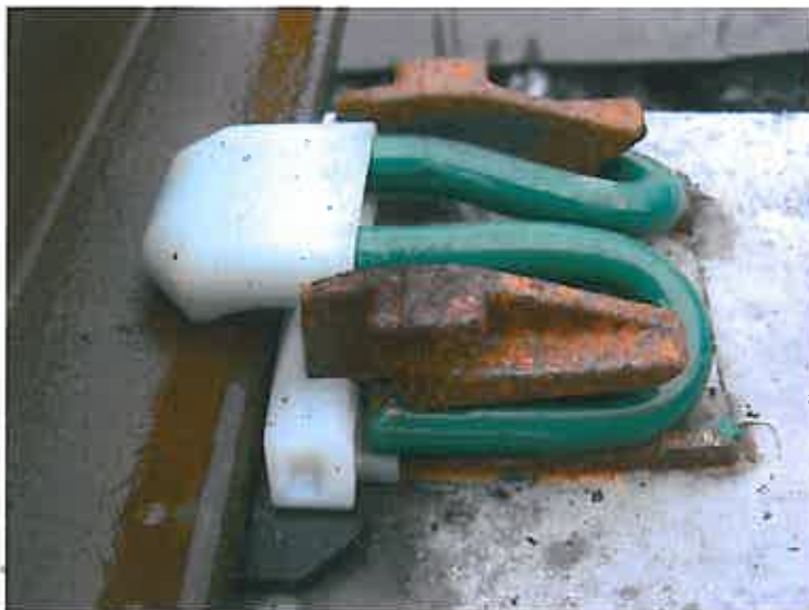
Fjädebygel Pandrol fastclip
