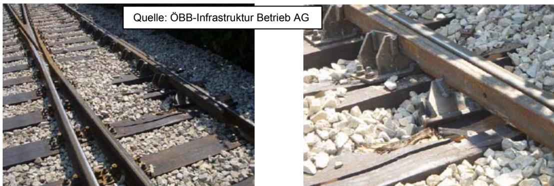
Abbildung 27 Entgleisungsspuren am Radlenker der W 51
