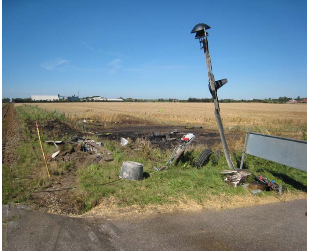
Figur 5. Beskadigelser ved overkørsel 233
