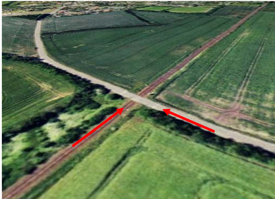
Figur 2. Luftfoto af overkørsel 233 ved Borris. Pilene på billedet angiver togets / henholdsvis mejetærskerens køreretning.
