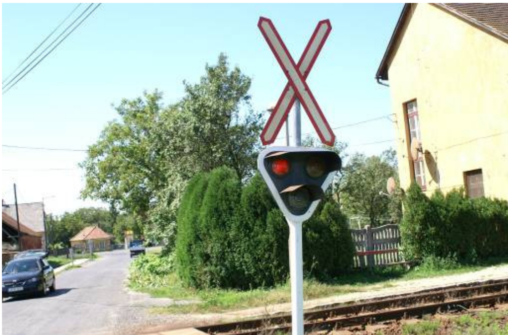
9. ábra: Az AS52 fénysorompó üzemszerű működése
