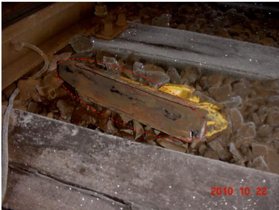
4. ábra: A rögzítősaru talpa
