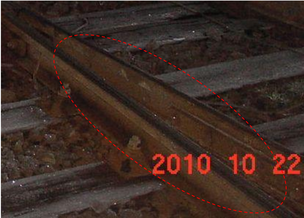
5. ábra: Csúszási nyomok a sínen
