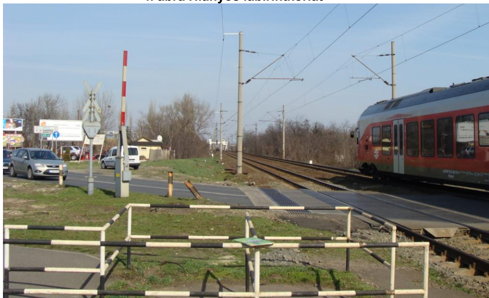
5. ábra A fénySOROMPÓ jelzése nem látható a labirintkorklát felől (a fénykép készítésekor a sorompó „zavar” állapotban volt, a képen látható vonat kb. 15 km/óra sebességgel haladt át az átjárón)
