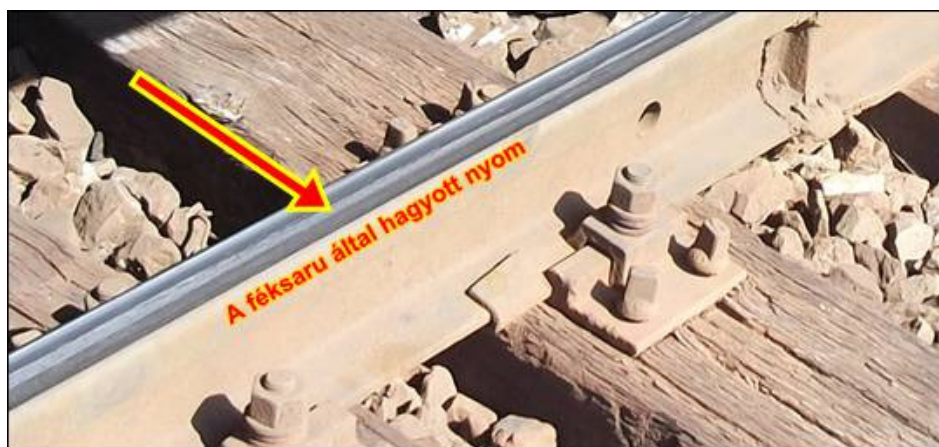
7. ábra: A féksaru által hagyott csúszási nyom a sín futófelületén
