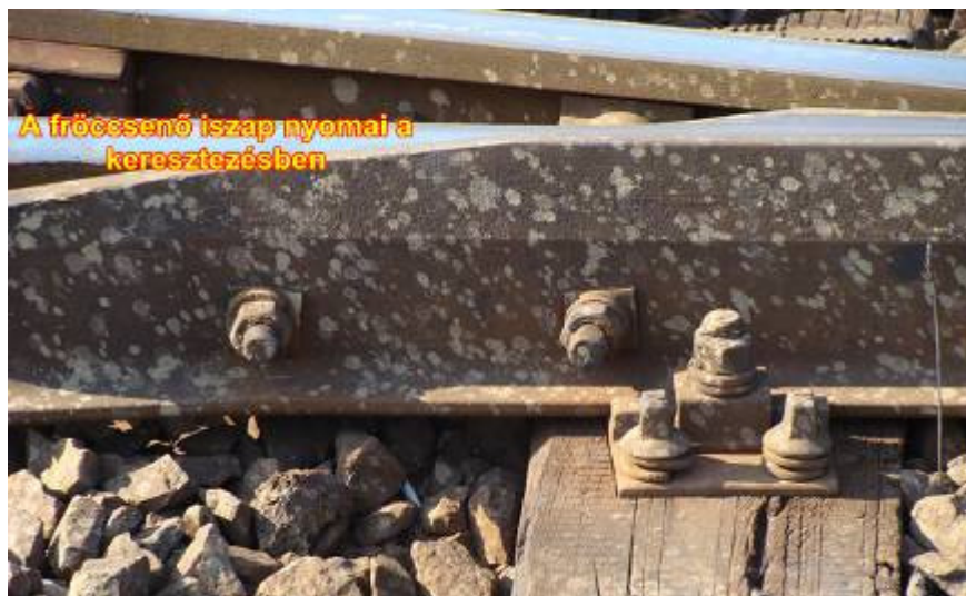
13. ábra: Lokális pályahiba a II. sz. keresztezésben
