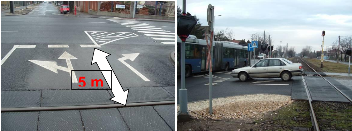
6. ábra Az útátjáró kialakításából adódó veszély
