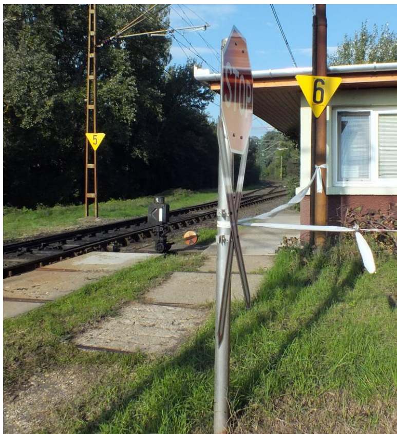
8. ábra A vasútüzemi épület által kitakart rálátás
