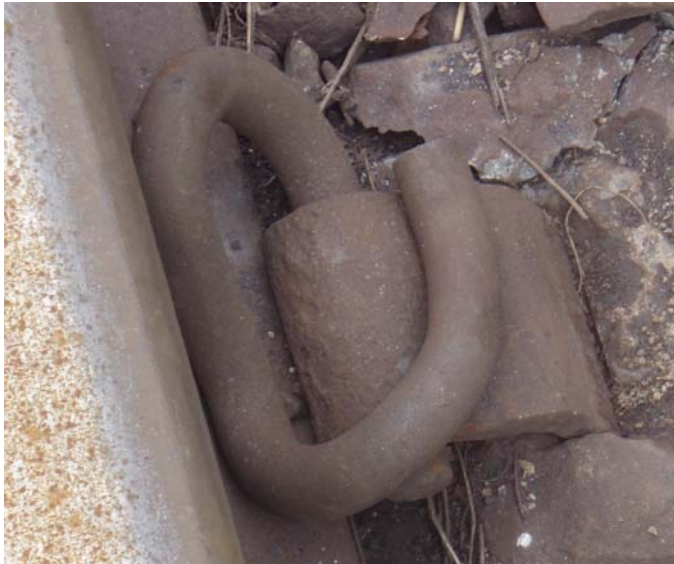
Abb. 11 Schienenbefestigung mit Federklammer der Bauart "Pandrol"
