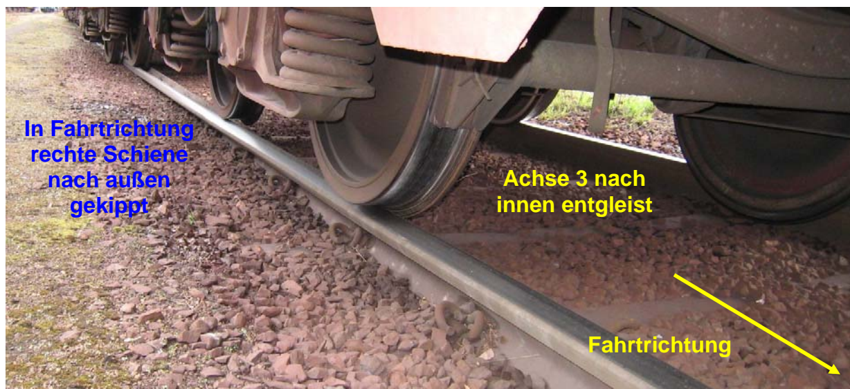
Abb. 6 Entgleister dritter und vierter Wagen von Z 47490, Blick von rechts
