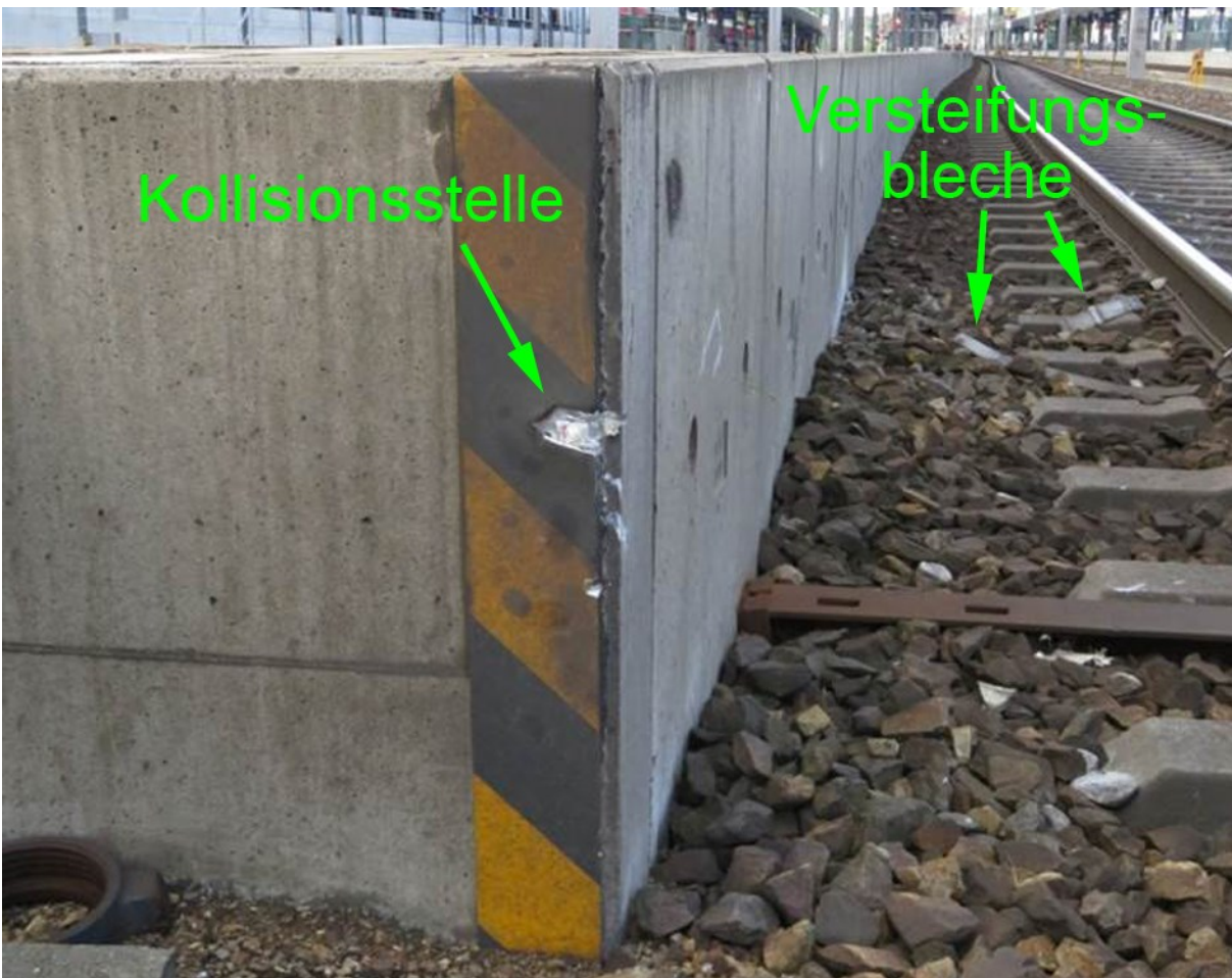
Abbildung 7: Bahnsteig mit Kollisionsmarke und Fahrzeugteilen im GI 204 (Quelle ÖBB PV AG)
