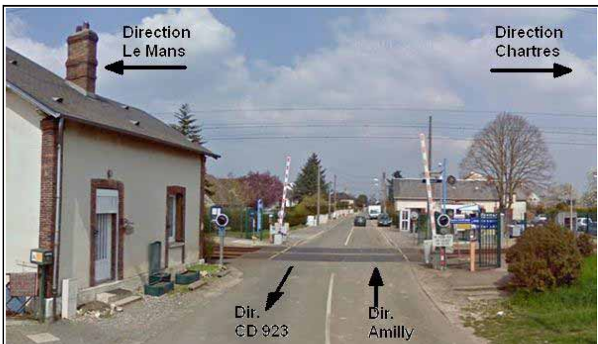
Figure 9 : Vue rapprochée du passage à niveau n° 40
