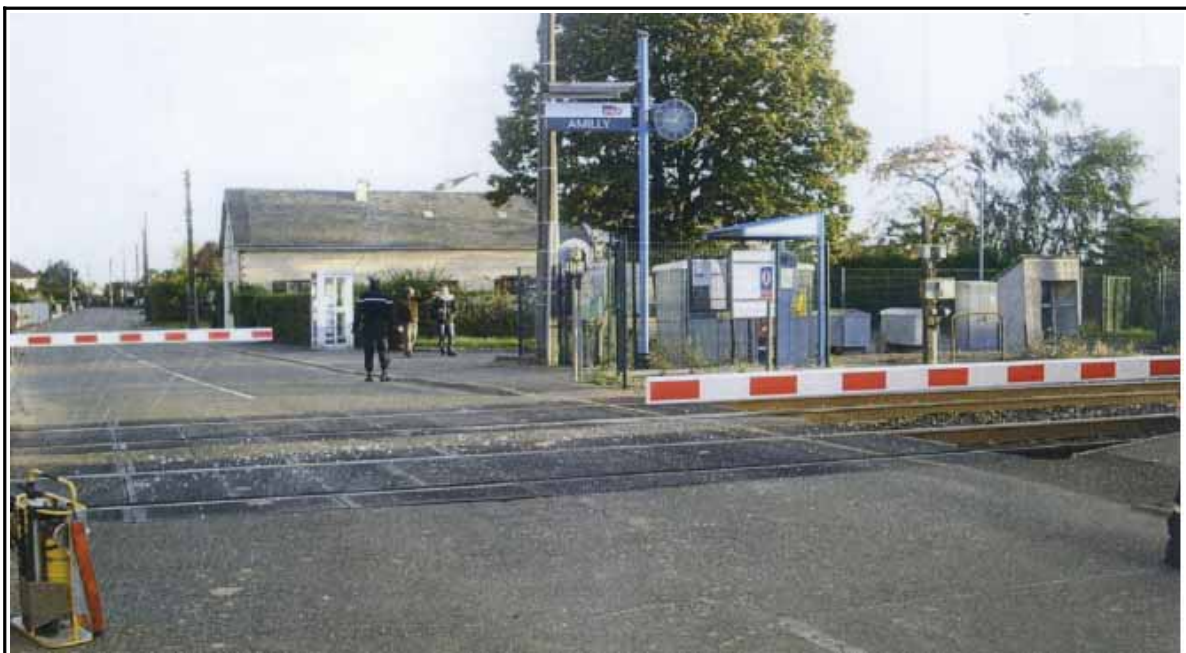
Figure 4 : Vue du passage à niveau lors de l'arrivée des secours
