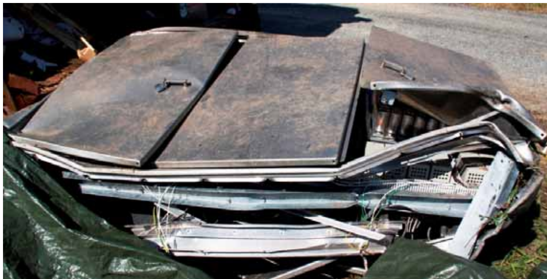
Kuva 19 Tuhoutunut turvalaitekaappi K266.
