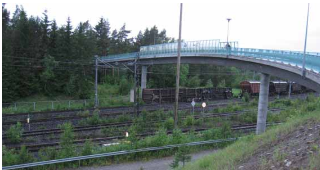
Kuva 4. Tavarajunan etuosan kaatuneet 17. ja 18 vaunu sekä kiskoille jääneitä vaunuja. (Kuva RHK)
