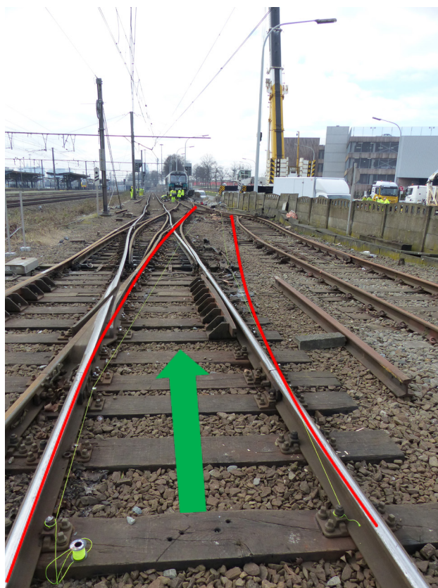
Foto: vanaf POD 2 rijdt het linkerwiel van de eerste bogie op de kraagschroeven.
