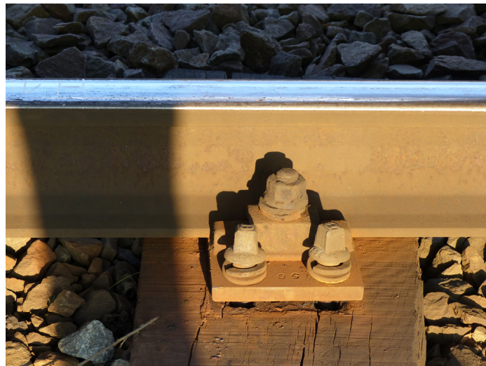
Foto overzijde POD 2: het rechterwiel van de 1ste bogie duwt het spoor open: de steunplaat wordt weggeduwd en de kraagschroeven komen omhoog.
