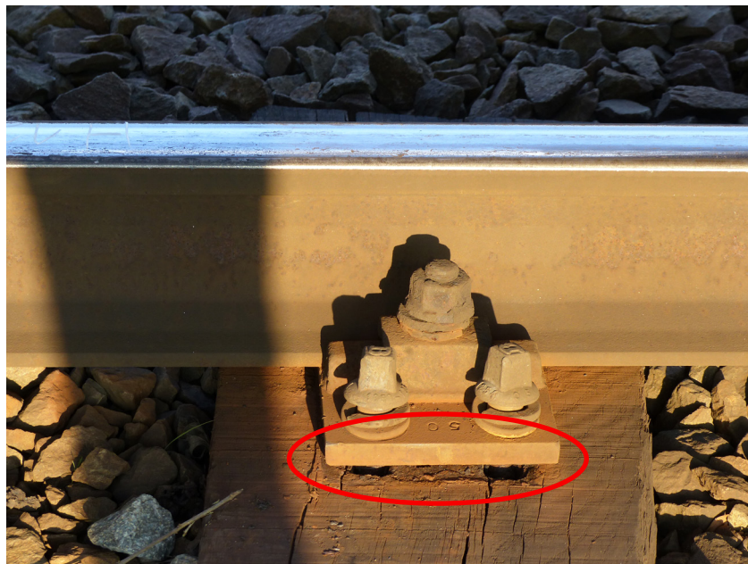
Foto: geovaliseerde boorgaten onder de pandrolplaat.
