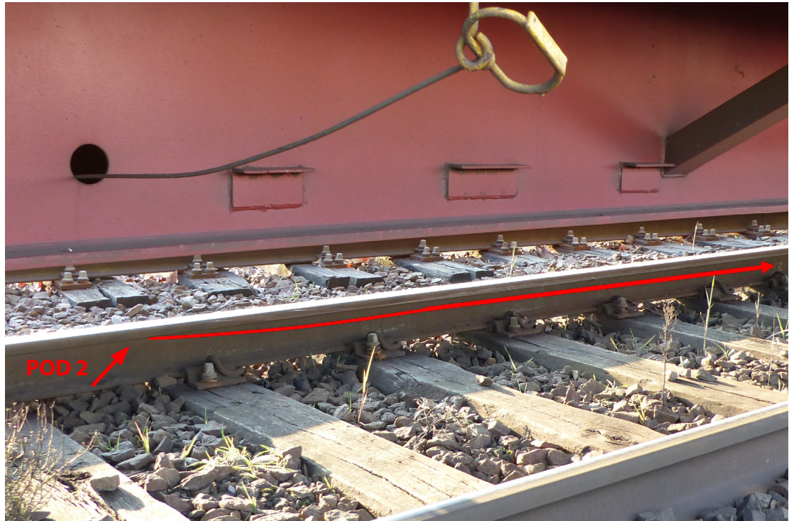
Foto: vanaf POD 2 rijdt het linkerwiel van de eerste bogie op de kraagschroeven.
