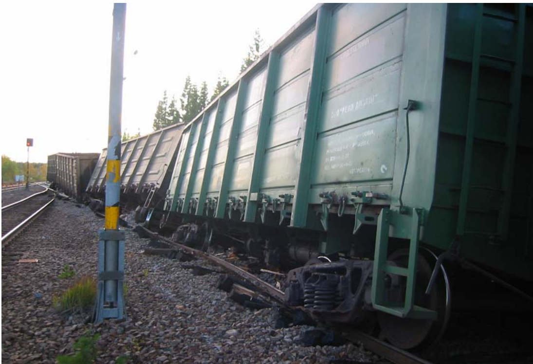
Kuva 3. Suistuneet vaunut rikkoivat rataa pahoin.
