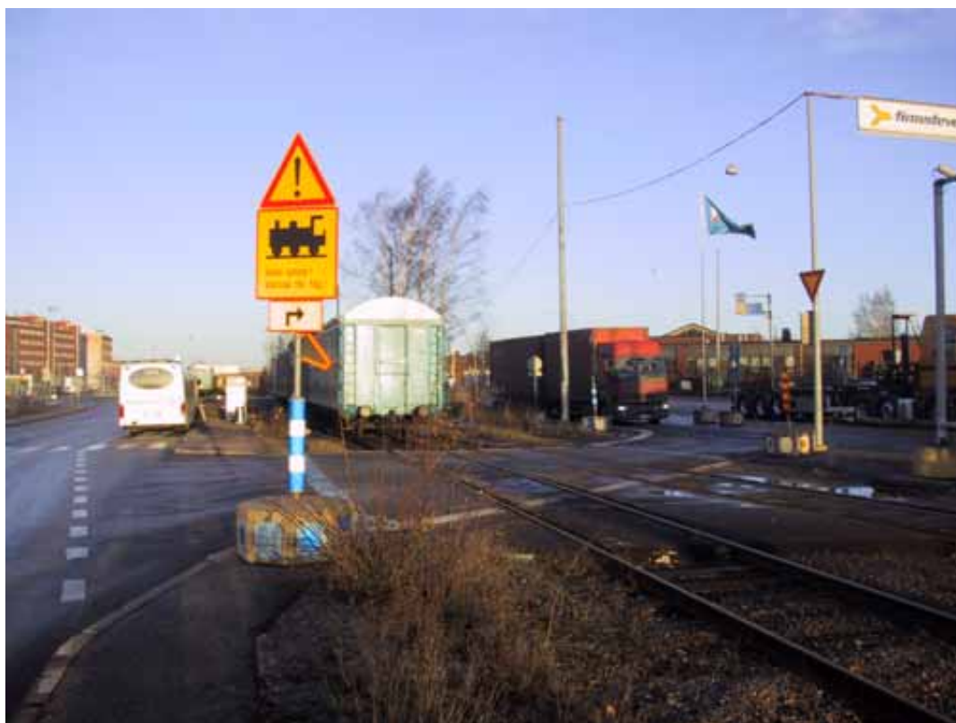
Kuva 3. Sataman porttien edessä olevasta tasoristeys. Kuorma-auto lähti ylittämään tasoristeystä samasta kohtaa kuin kuvassa näkyvä punainen auto.
