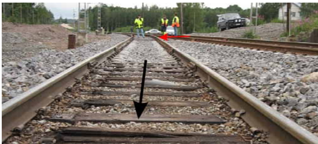
Kuva 3. Suistumisjäljet alkoivat kulkusuuntaan vasemmassa kiskossa, jossa oli jälki laipan noususta kiskon päälle (punainen nuoli). Junan kulkusuunta merkitty mustalla nuolella.
