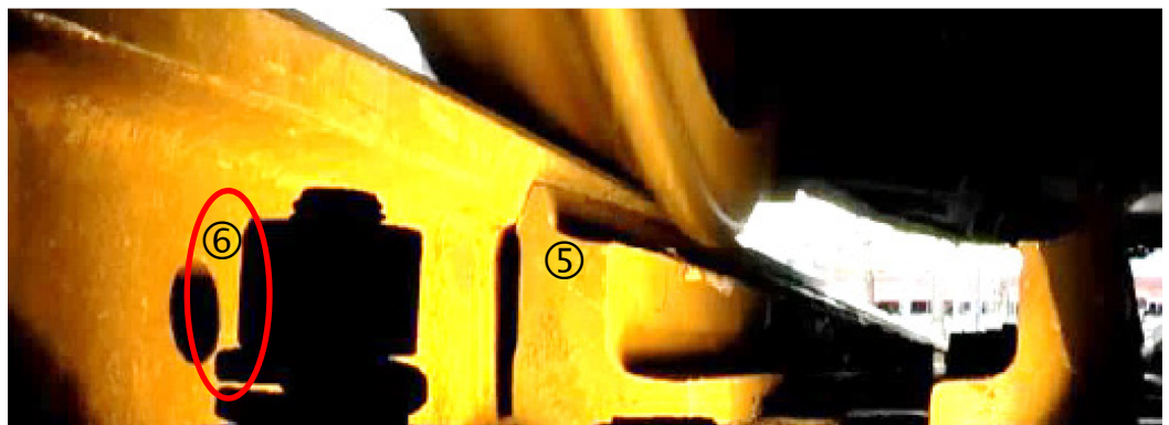
Abbildung 41: Der Spurkranz hat Kontakt mit der Weichenzunge und drückt sie gegen die Stockschiene ⑤, die gekippt bleibt ⑥ unter der Last der Querkraft (Kreis, Vergleich mit Abbildung 39 und Abbildung 40) (Quelle: SBB).
