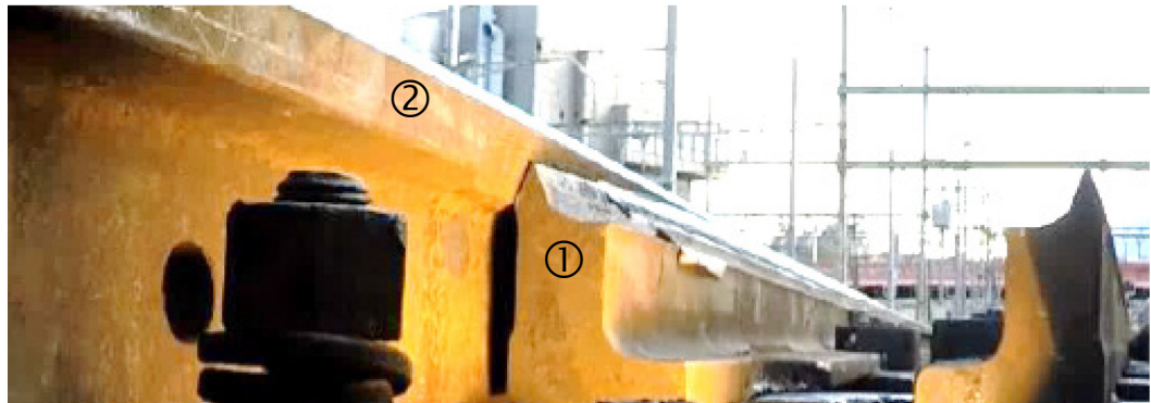
Abbildung 39: Weichenzunge ① an der Stockschiene ②anliegend (Quelle: SBB).
