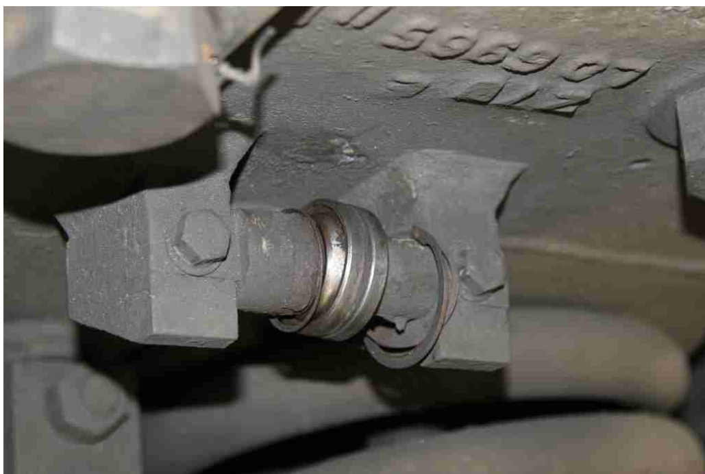
Obr. č. 6: Poškození horní konzole tlumiče Zdroj: Drážní inspekce
