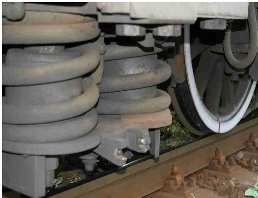
Obr. č. 3: Chybějící tlumič sekundárního vypružení 1. podvozku
