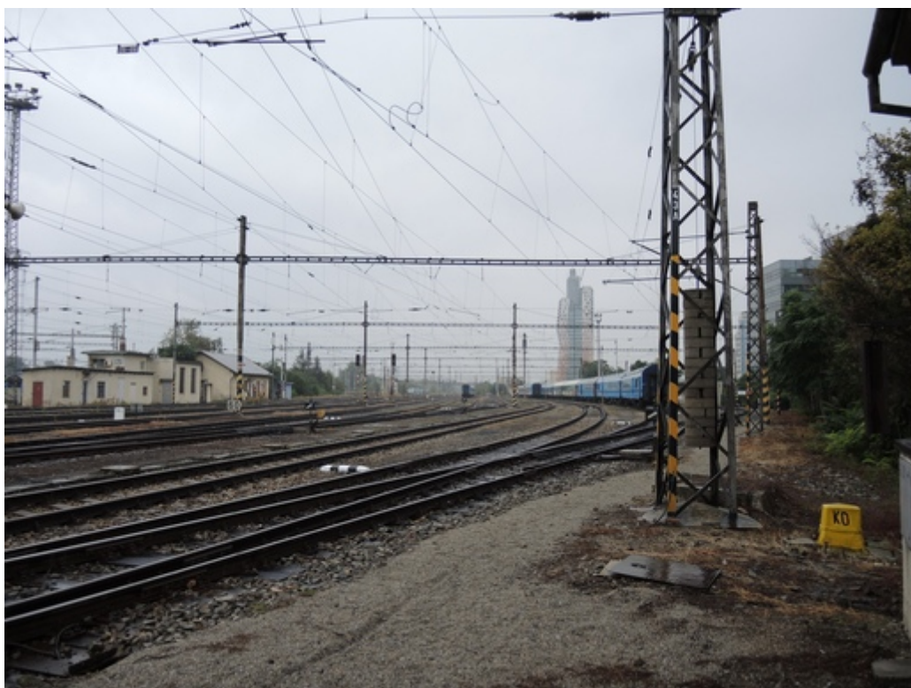
Obr. č. 8: Pohled na výhybku č. 23 z místa určeného pro sledování posunů
