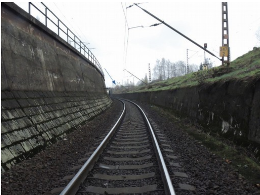
Obr. č. 5: Návěstidlo LV ze vzdálenosti 201 m
