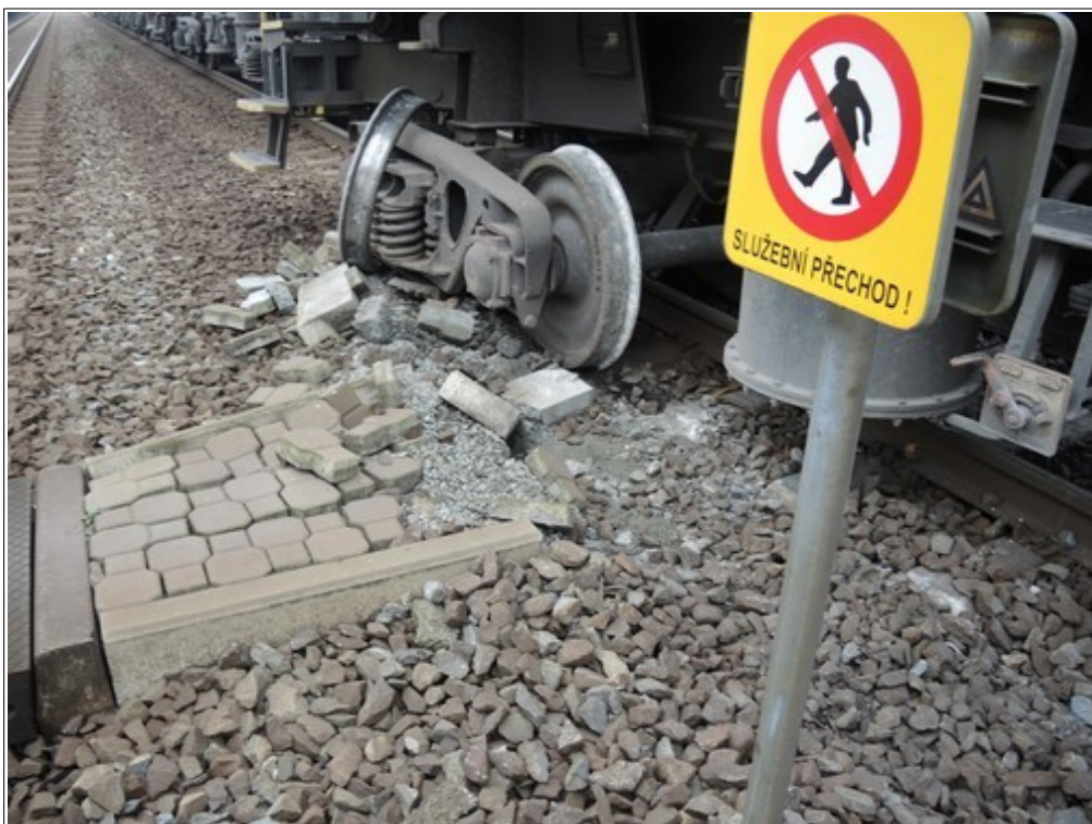
Obr. č. 7: Pohled na poškozený služební přechod a vykolejený podvozek TDV 88 54 9200 105-6 v konečném postavení po MU.
