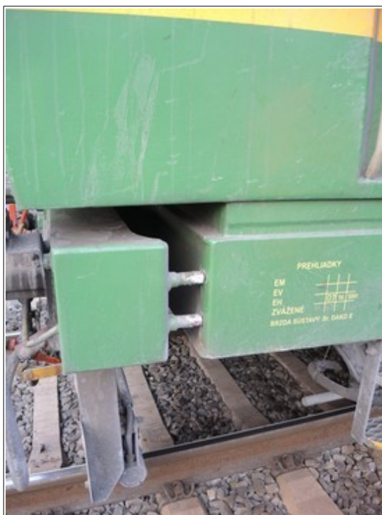
Obr. č. 4: Pohled na narážky ohnutého předního (deformačního) čelníku HDV vedoucí sekce 131.070-5 dvoudílného HDV 131.069-7/070-5 po srážce s návěstním TDV vlaku Nex 49735. Zdroj: DI
