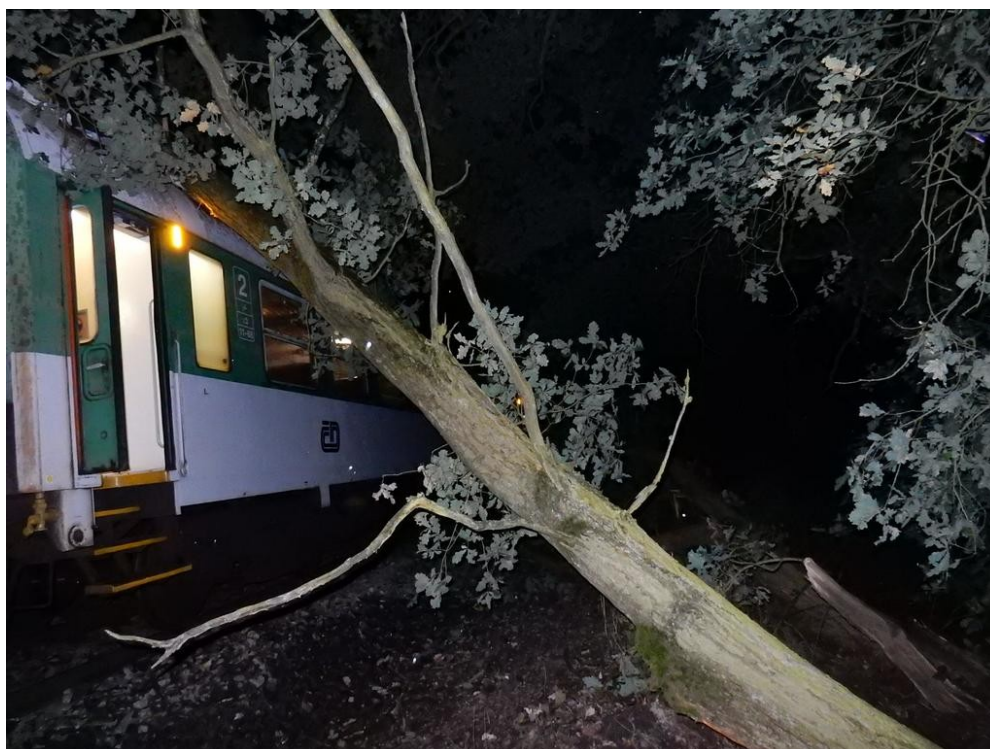
Obr. č. 3: Pohled na poslední spadlý strom zaklíněný na střeše posledního DV
