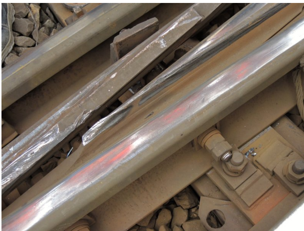
Obr. č. 10: Přídržnice dodatečně vložená ve výhybce 8a/b.
