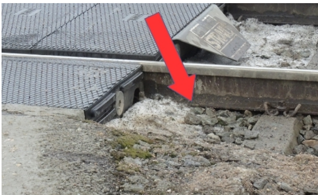
Obr. č. 22: Pohled na místo uvážnutí pravého předního kola NA IVECO Zdroj: DI
