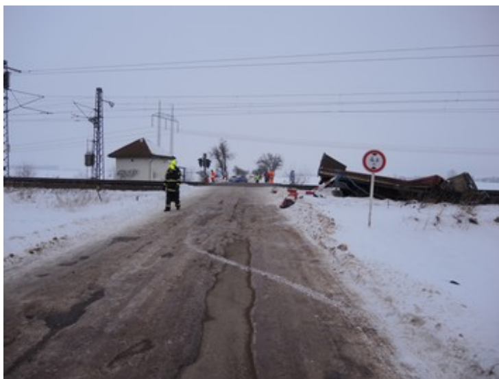
Obr. č. 15: Stav pozemní komunikace v době MU
