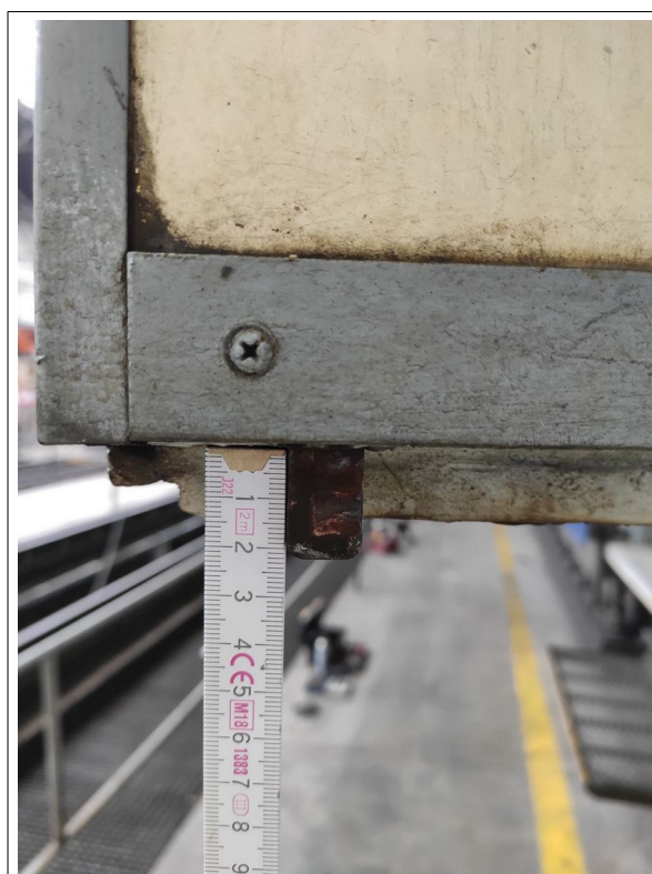
Obr. č. 10: Ukázka vysunutí dolního čepu na jiném HDV (854.012-2) v depu Brno-Horní Heršpice
