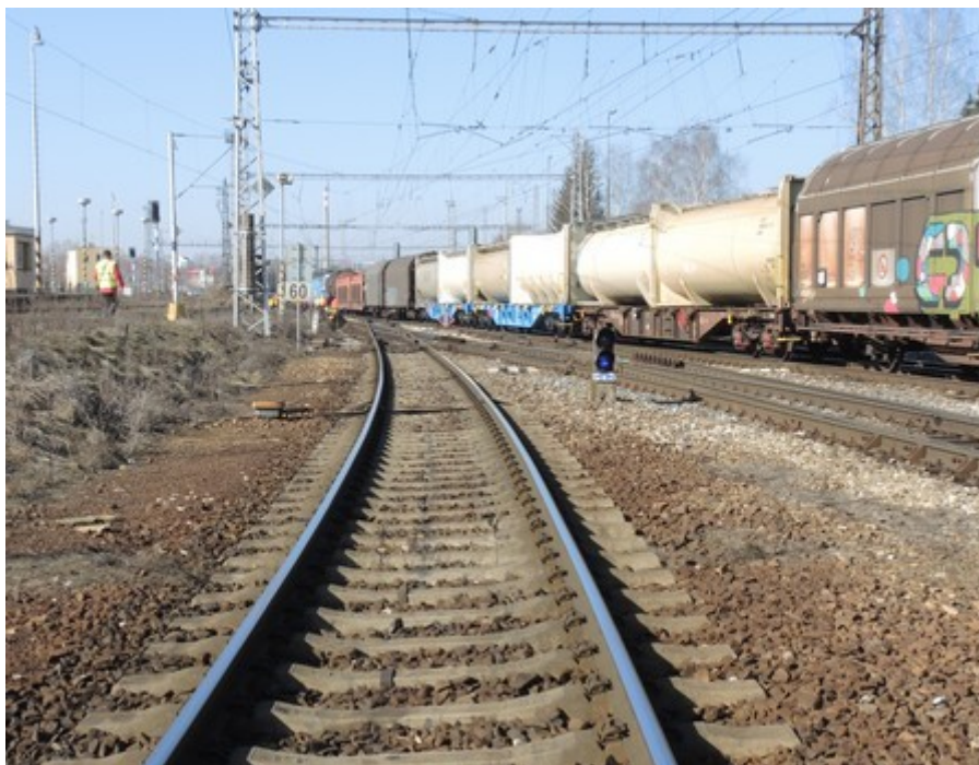
Obrázek 3: Pohled na návěstidlo Se7.
