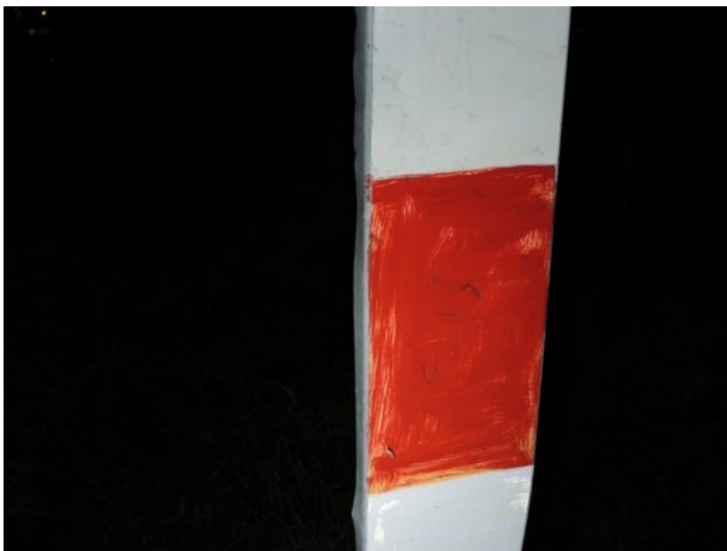
Obr. č. 9: Chybějící reflexní provedení Výstražného kolíku
