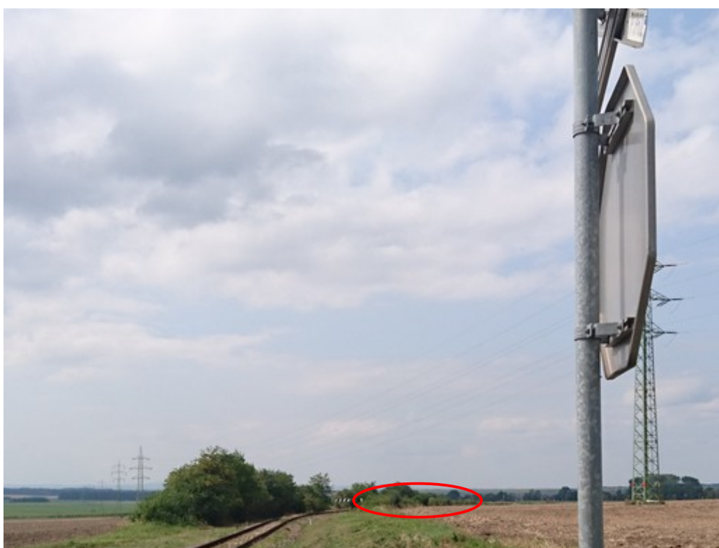
Obr. č. 10: Křoviny zkracující délku rozhledu L_p
