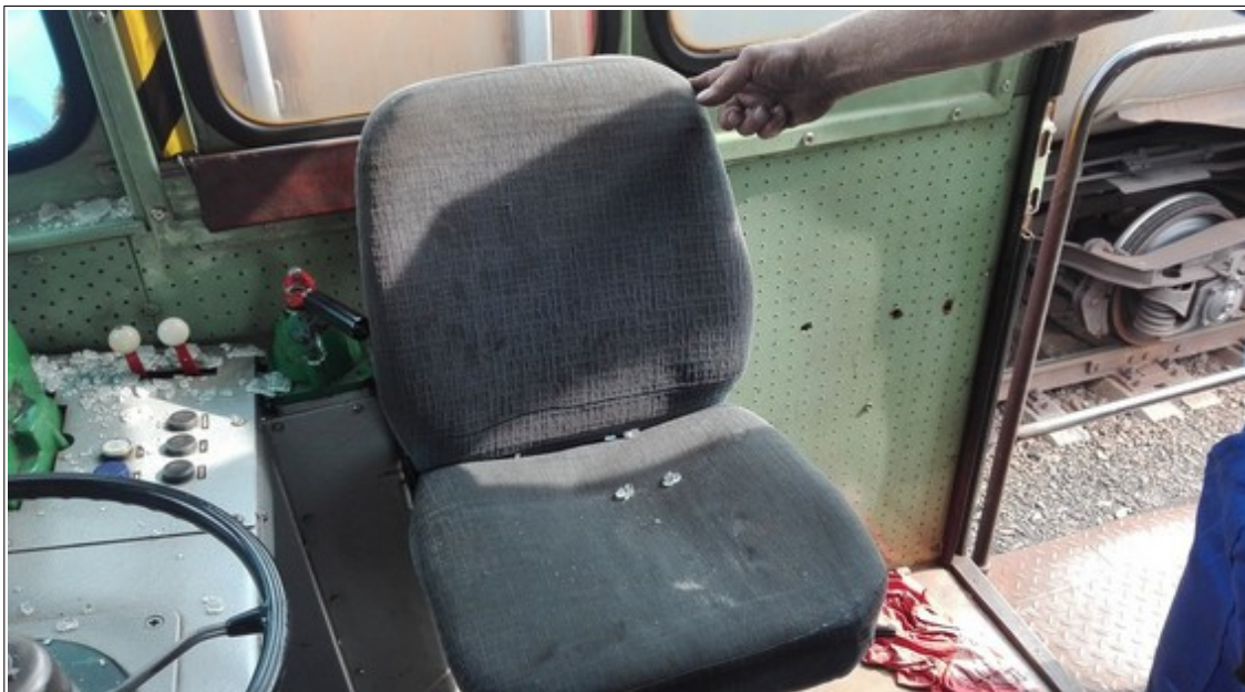
Obr. č. 4: Pohled na kontakt opěradla sedačky strojvedoucího s rukojetí brzdíče DAKO-BP.
