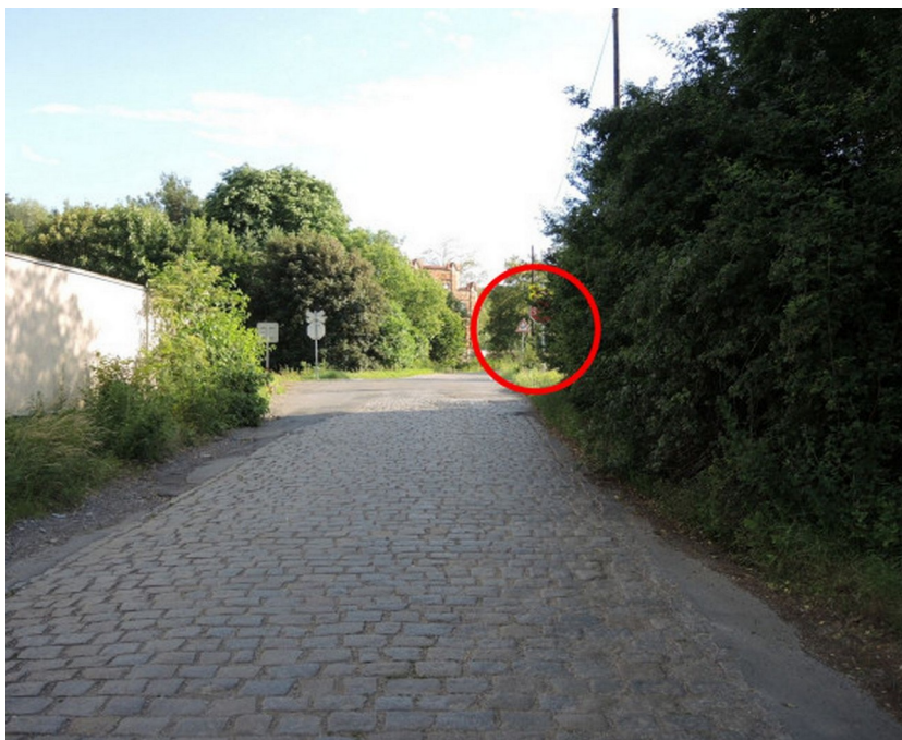
Obr. č. 7: Výhled na svislé dopravní značky na přejezdu z předepsané vzdálenosti (25 m) Zdroj: DI
