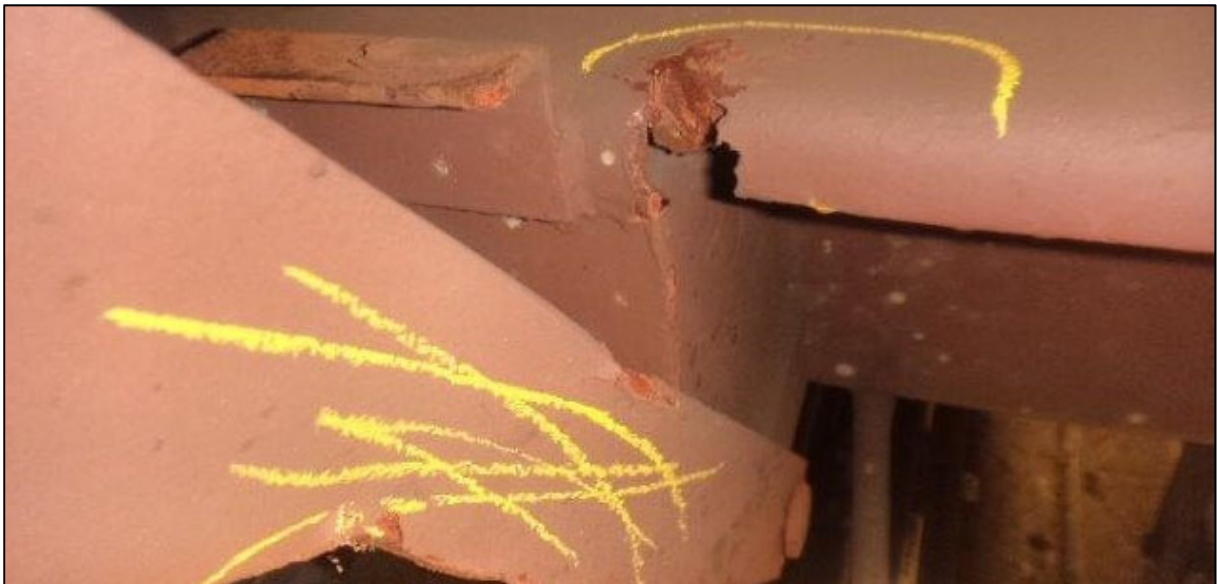
Abbildung 13: Beschädigung an der Überfahrbrücke am Wagen 23 54 4366 259-0 10
