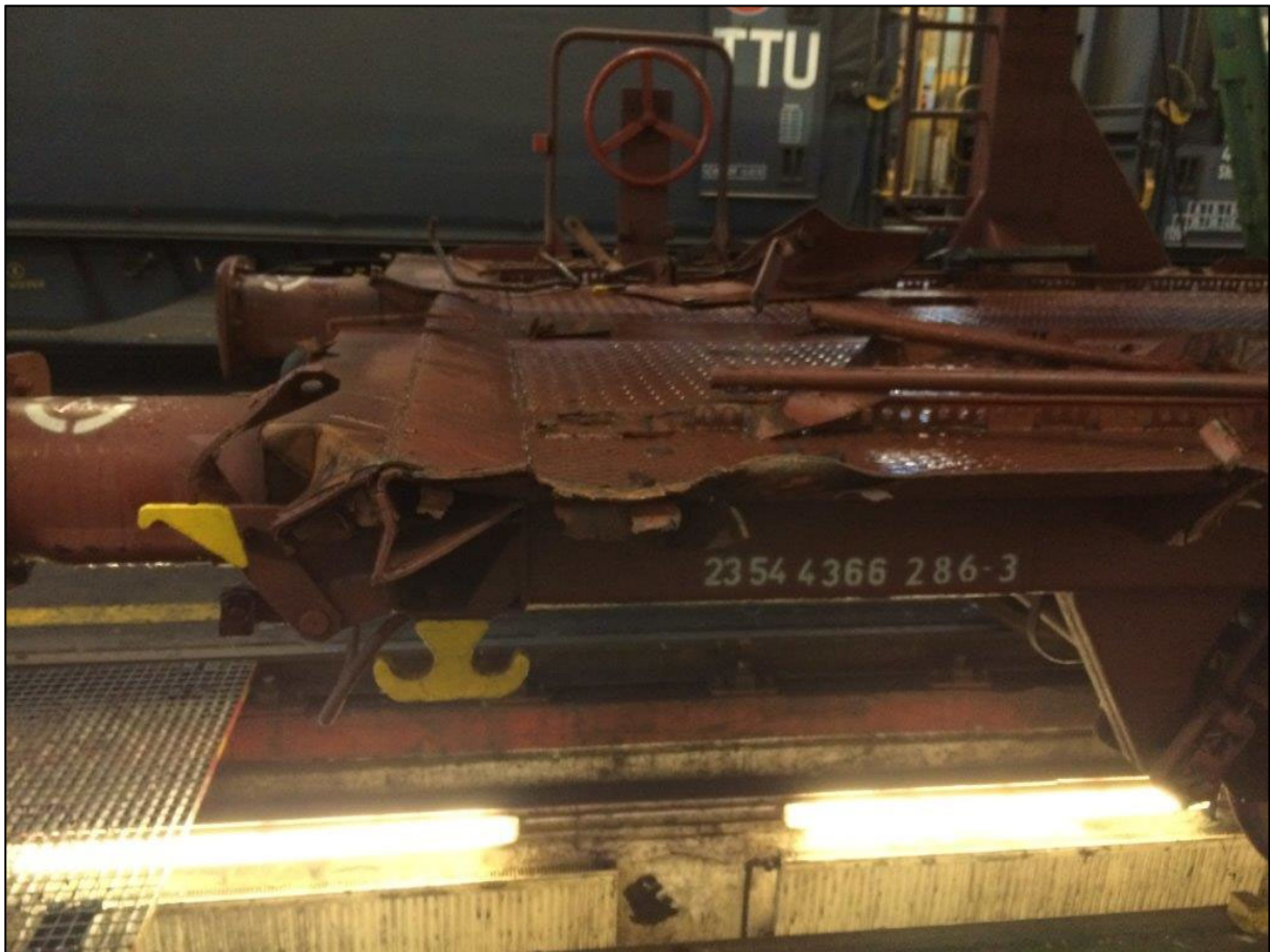
Abbildung 14: Beschädigte Bodenbleche am Wagen 23 54 4366 286-3 11
