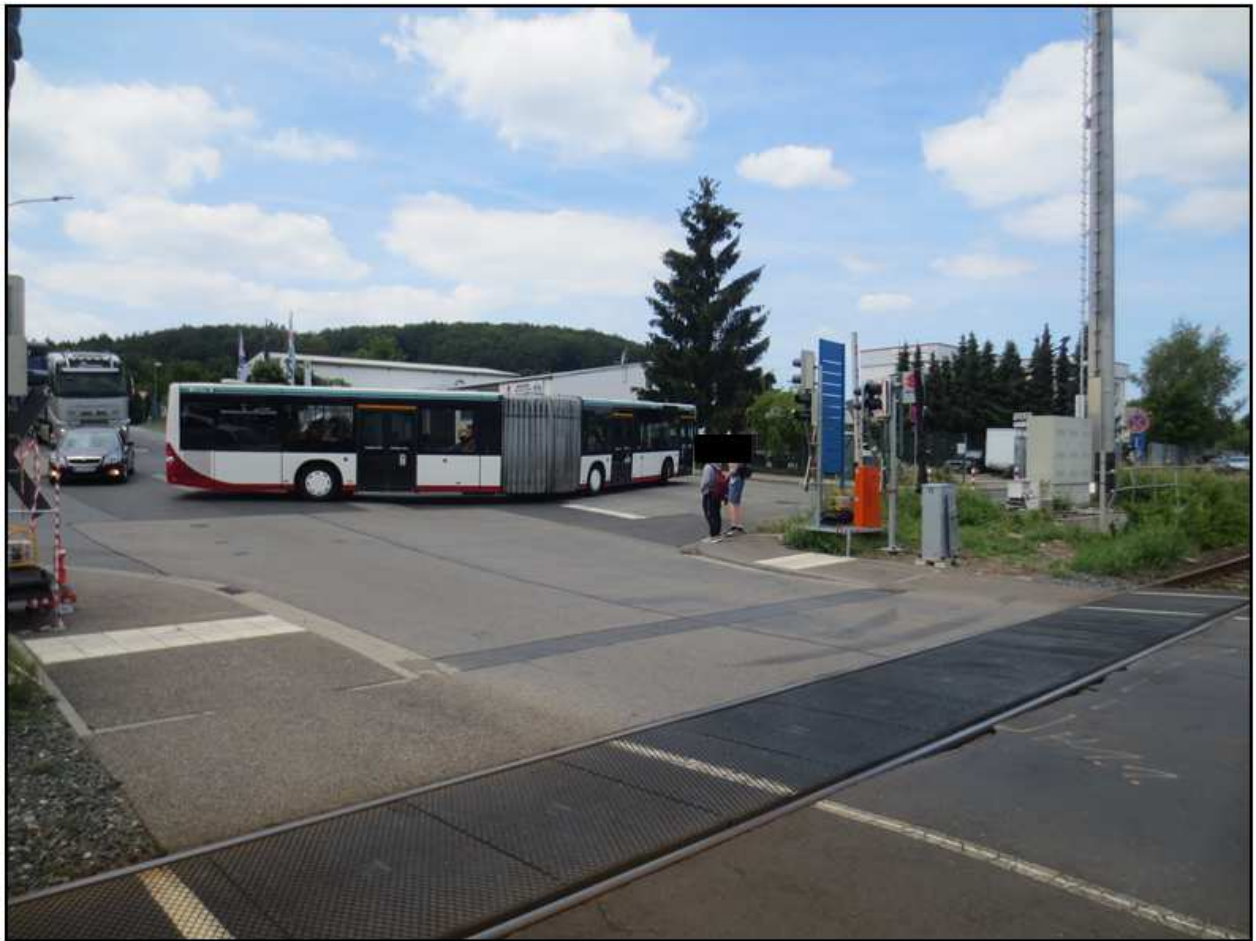
Abb. 7: Blockierte Räumung des BÜ innerhalb der Räumstrecke durch Gelenkbus
