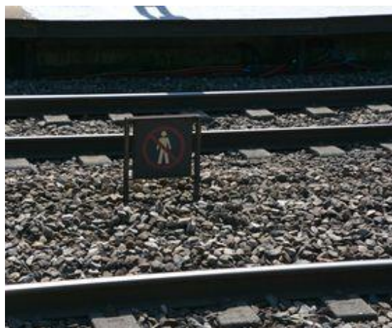
Foto 1 Skiltning af overgang forbudt - mellem sporene
