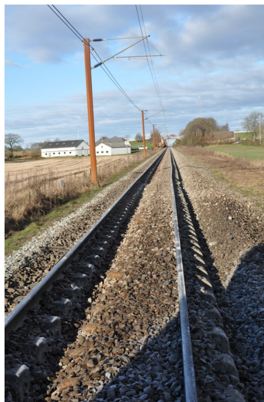
Foto 2 Det ødelagte spor set bagud fra toget (i retning mod Farris)
