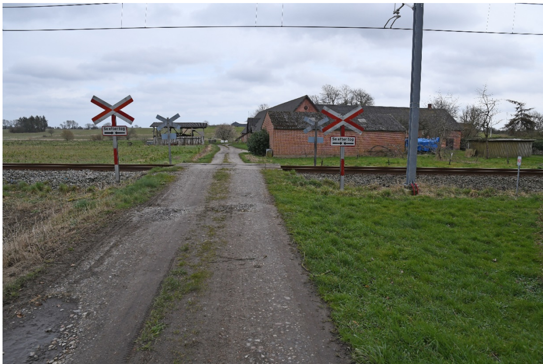
Overkørslen med A 74,1 og UA 72, ca. 10 m fra overkørslen (17-03-2020)
