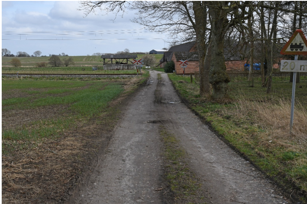
Overkørslen set på ca. 60 meters afstand. A 72 ses til højre med undertavle "20 m" (17-03-2020)
